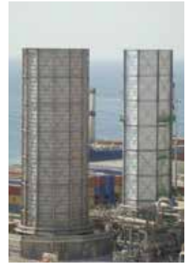
全封闭式地面火炬
